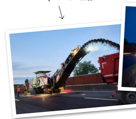
1. Rabotage de la chaussée
