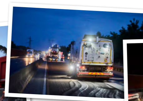
2. Nettoyage de la chaussée
