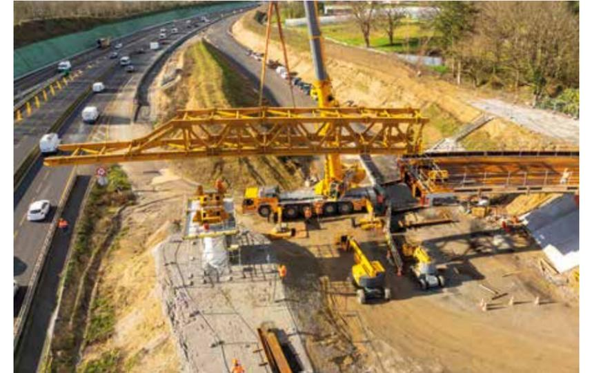
Assemblage des 44 éléments de la charpente métallique du viaduc ouest (liaison A11 - périphérique est).
