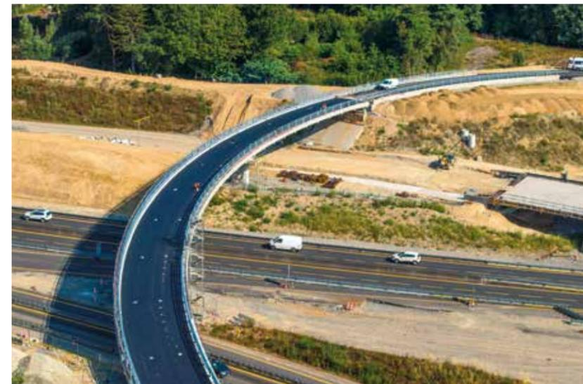
Réalisation des dispositifs de retenue en béton et application des enrobés sur le viaduc ouest.
