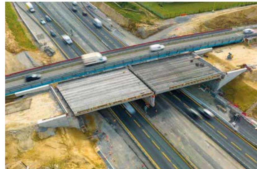
Construction du pont de la route de La Chapelle-sur-Erdre avec la pose des 26 poutres préfabriquées du tablier.
