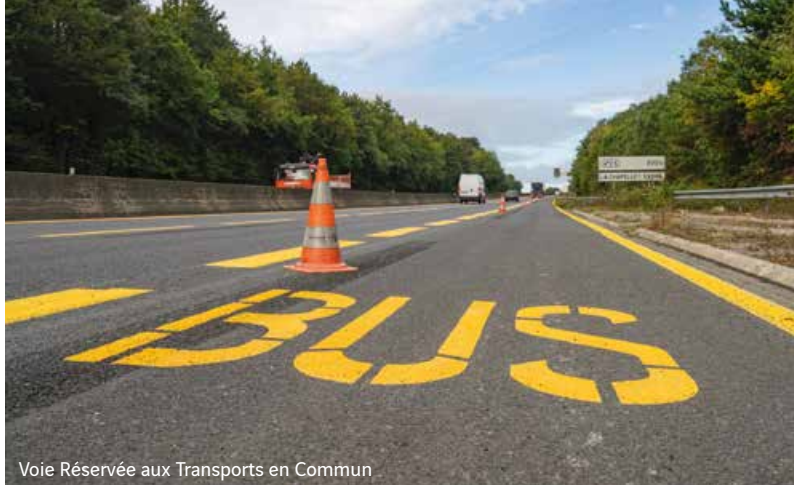
Chaussée à circulation douce « Chaucidou »
