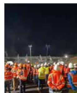
Visite des collectivités pour la démolition du pont. Route de La Chapelle-sur-Erdre.
