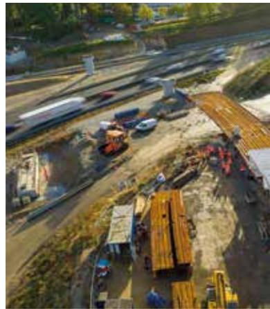
Mars 2023 : Pose des poutres du pont de la route de la Chapelle-sur-Erdre
