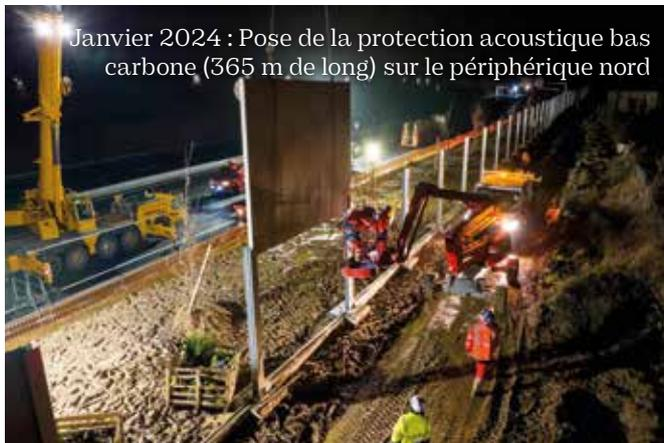
Janvier 2024 : Pose de la protection acoustique bas carbone (365 m de long) sur le périphérique nord
