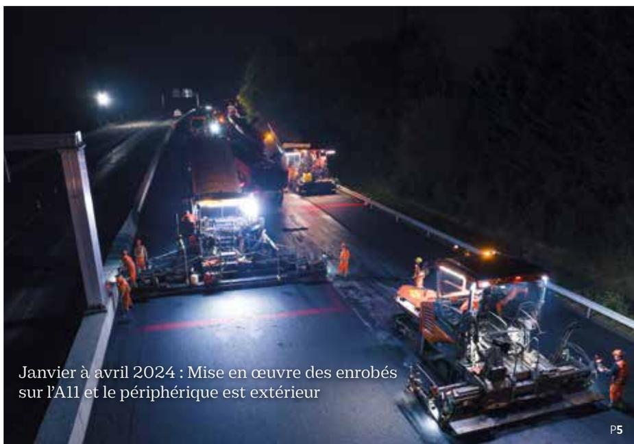
Janvier à avril 2024 : Mise en œuvre des enrobés sur l’A11 et le périphérique est extérieur
